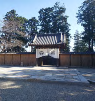
室町時代に鎌倉の建長寺派明月院の正門として建てられた「明月門」
