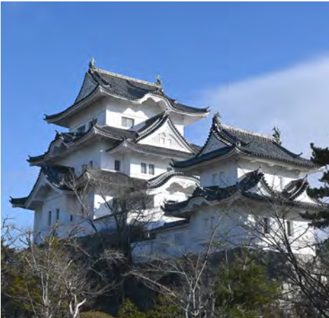
築城の名手である藤堂高虎ゆかりの伊賀上野城
