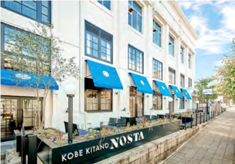
旧北野小学校の校舎を改装して開業した、ノスタルジックな「食」の複合施設「神戸北野ノスタ」
