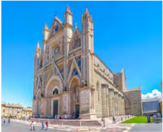
扉口を含め細部にわたり、細かな装飾技術が施されたドゥオーモ
