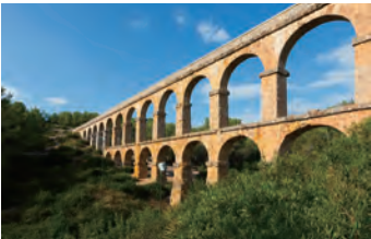
ローマ時代のラス・ファレラス水道橋
