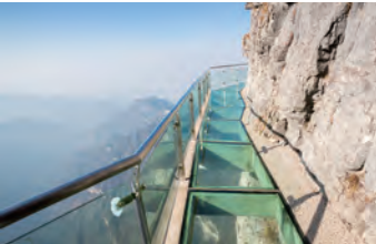
絶景にかかるガラス遊歩道
