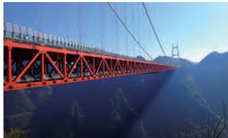
矮寨大橋は、アジアの長さ(約1キロ)を誇る(視察写真)
