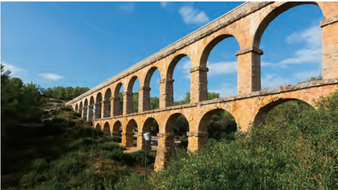
ローマ時代のラス・ファレラス水道橋
