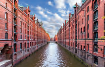
旧市街の倉庫街
