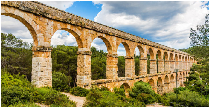
見事なアーチが見られるラスファレラス水道橋 諸説ありますが、悪魔が作ったことから「悪魔の水道橋」の異名もあります
