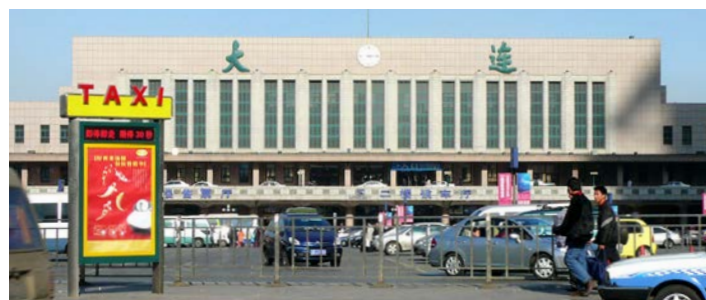
上野駅と同じ構造で日本時代に建てられた大連駅
