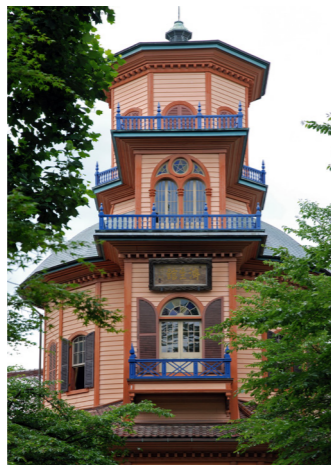
旧済生館病院本館 (山形市郷土館)
