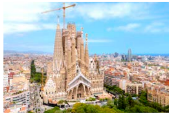
着々と建設が進むサグラダ・ファミリア（イメージ）
